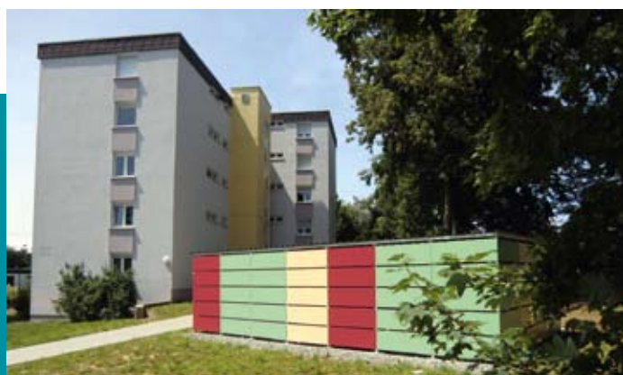
Aufzugsanbau Haus Leonhard
