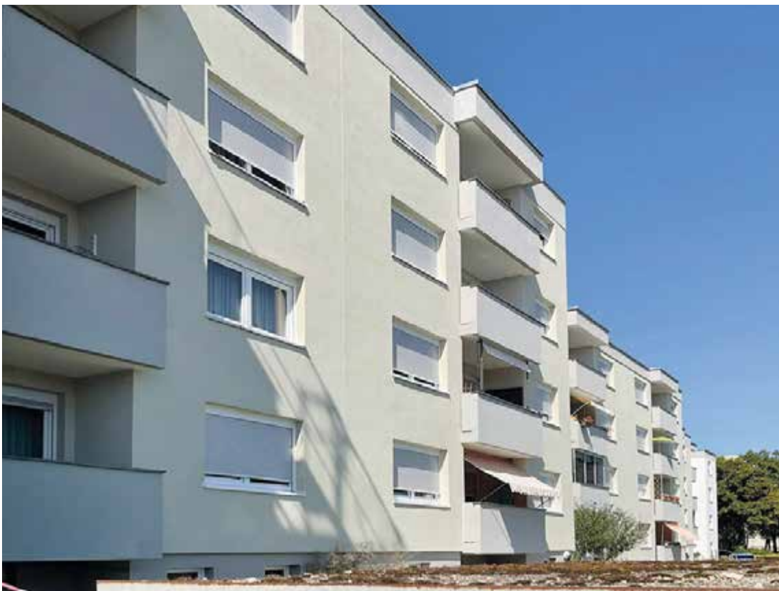
Sanierungsmaßnahmen Haus Konrad-Adenauer-Straße 18-26, Tarunstraße 11+13
