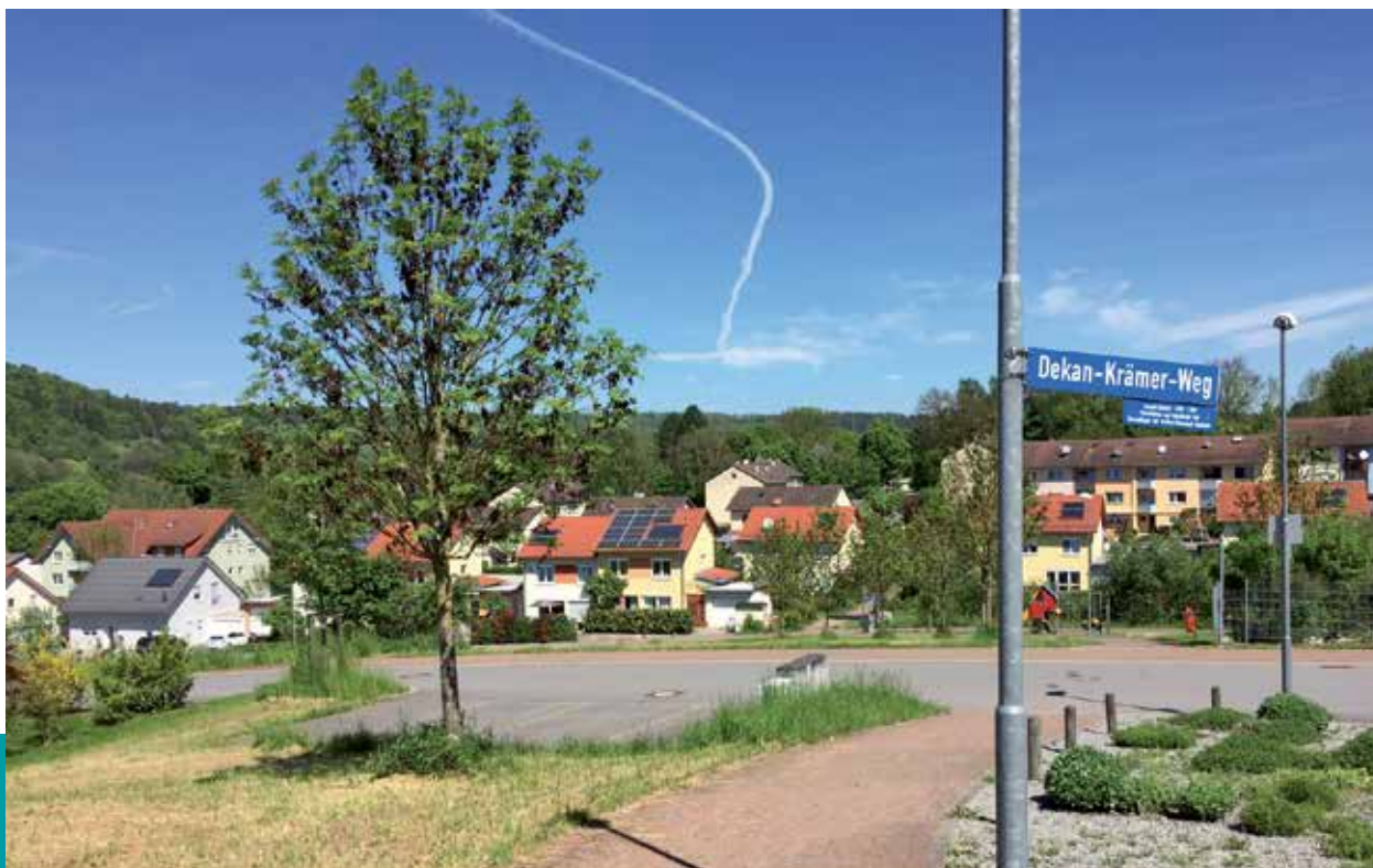
Blick auf das Grundstück C vom Eingang ins Baugebiet Mittel
