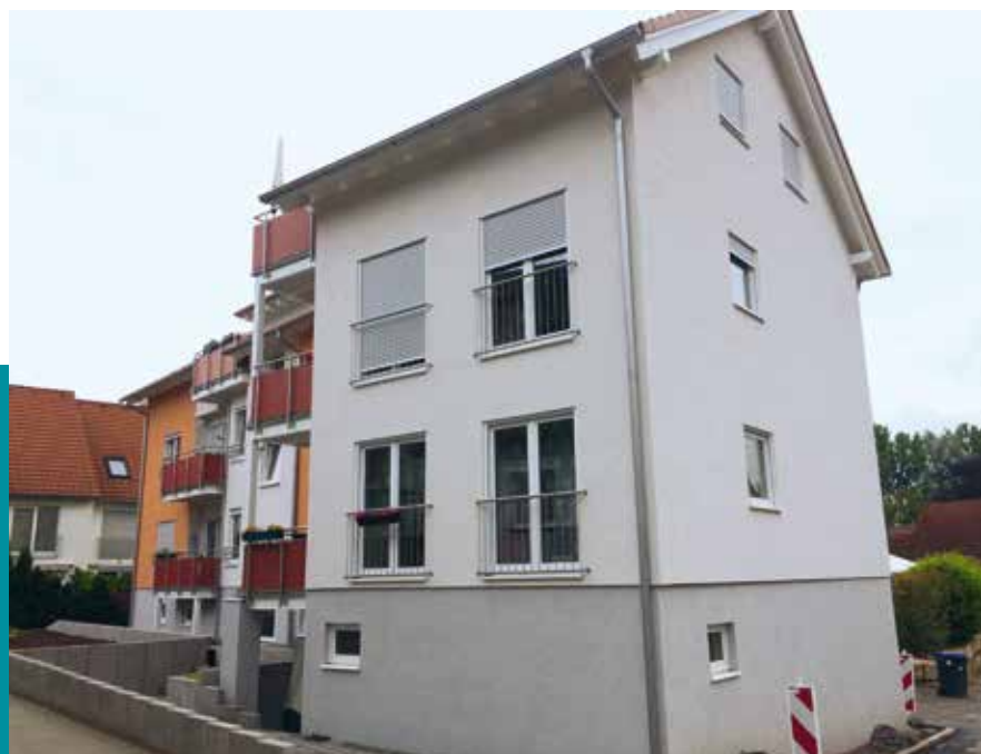
Neubau in Untereisesheim West- und Ostfassade
