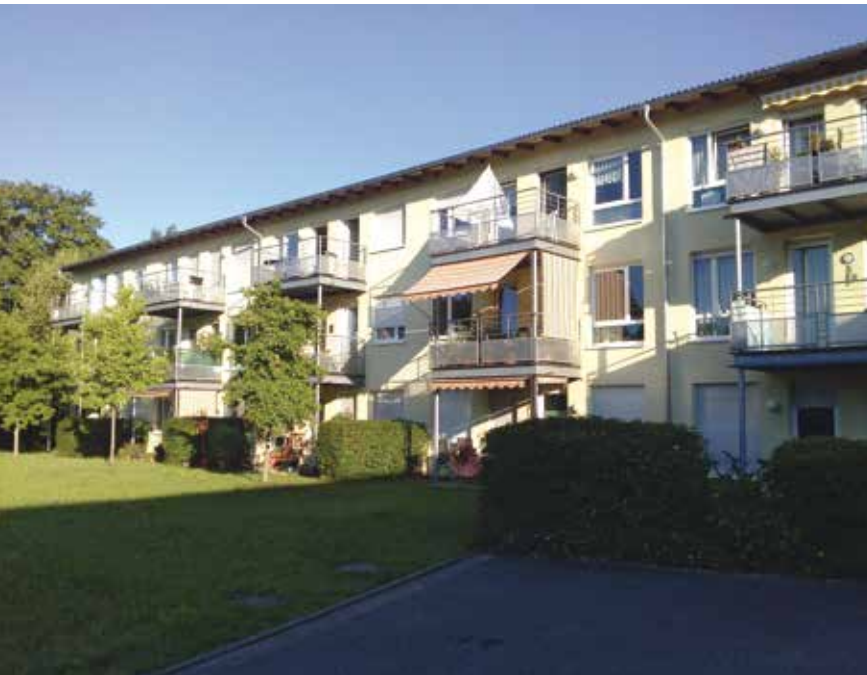
Seniorenwohnanlage „Kapplersgärten“ in Neckarbischofsheim
